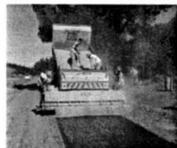
Besig met herseëlwerk
